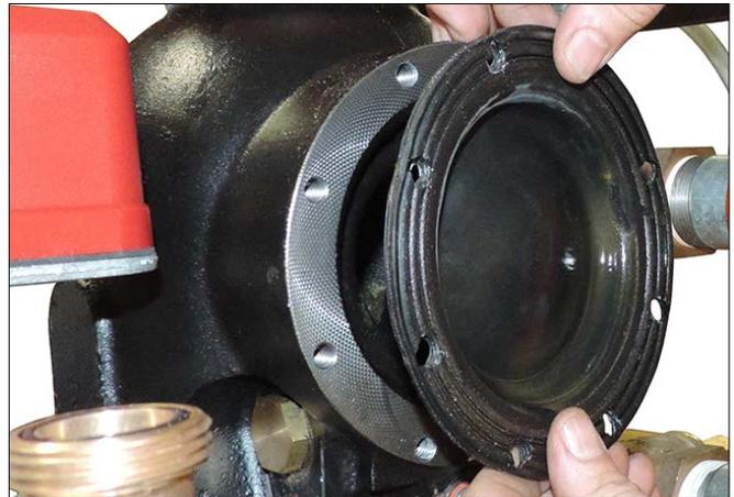
4. 從閥體上拆下隔膜。將隔膜扔掉。
