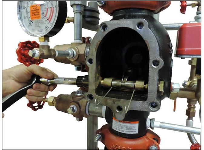
9. 確認在每個閥瓣軸襯套上都安裝一個閥瓣軸襯套 O 形密封環。
