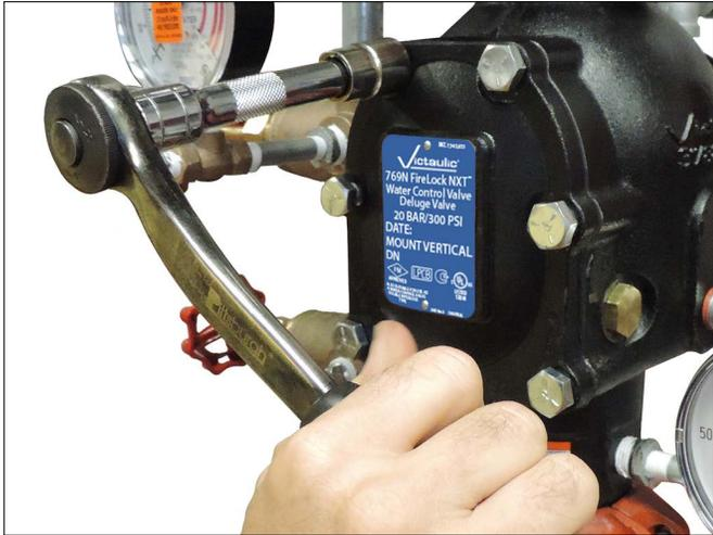
4. 將蓋板/蓋板密封墊圈對準閥門。確認閥瓣彈簧臂旋轉到安裝位置。將所有蓋板螺栓都擰入蓋板/閥體中。
