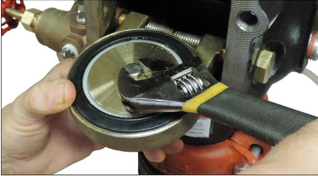
2. 從閥瓣密封上拆下密封裝配螺栓/螺栓密封墊。
