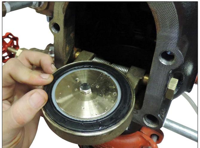
14. 從閥體中旋出閥瓣。檢查閥瓣密封和密封定位環。擦去所有污染物、灰塵和礦物沉積物。將閥體閥座環中被堵塞的所有孔口清潔乾淨。**請勿使用溶劑或磨料。**
