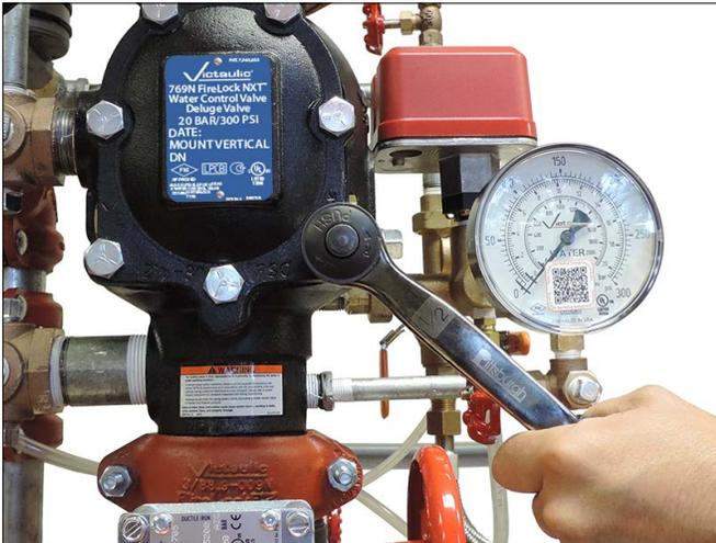
11. 從系統中釋放全部壓力後，緩慢鬆開蓋板螺栓。**註：**在所有蓋板螺栓都鬆開之前，請勿拆下任何蓋板螺栓。
